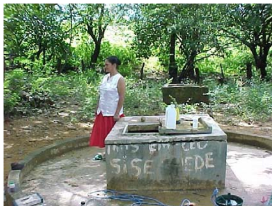
Pozo comunal de El Mojón en noviembre de 2003
